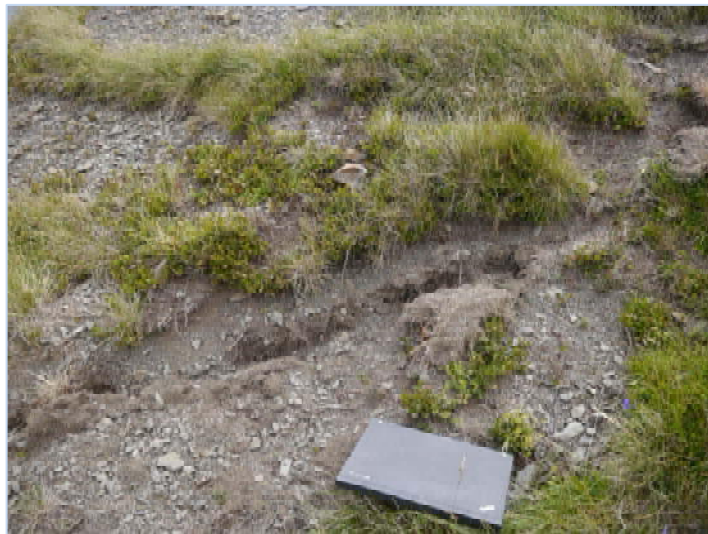
Tres Güegas, parcela oeste. Zanja tapada por donde discurre el tubo del cañón de nieve que toca la parcela occidental.
