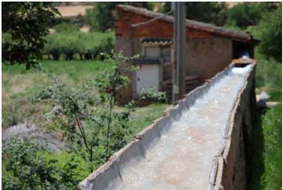
Captación del aluvial del río Manubles para complementar los riegos con aguas del río (Zaragoza)
