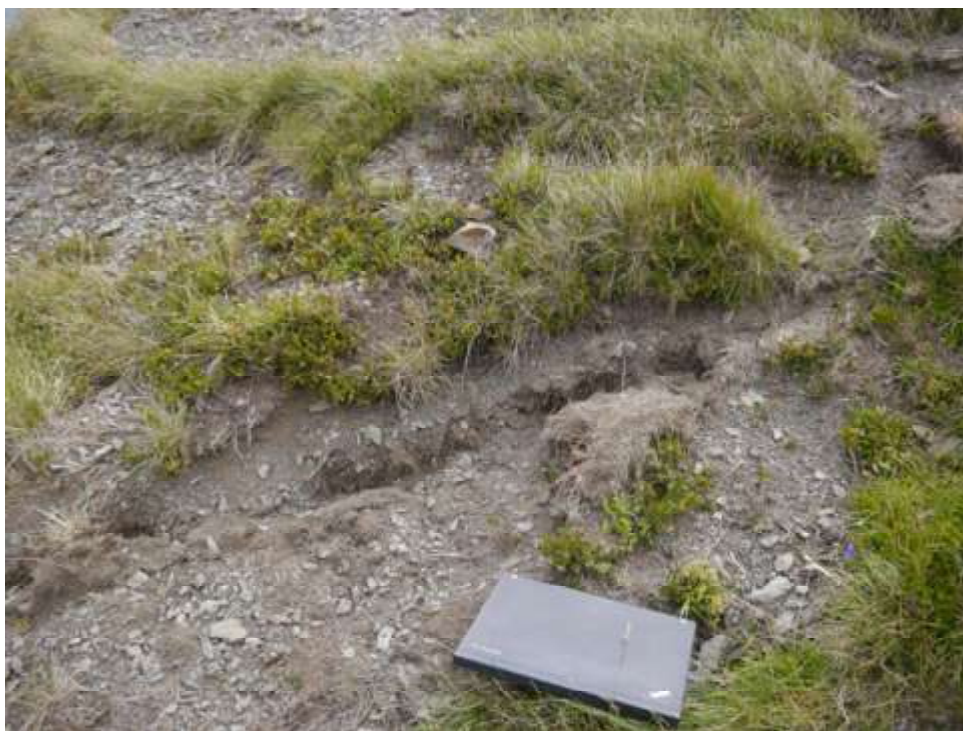
Tres Güegas, parcela W. Zanja tapada por donde discurre el tubo del cañón de nieve que toca la parcela occidental.
